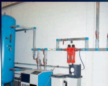
Red de distribución en aluminio para aire comprimido, vacío y gases no peligrosos, desde 20 a 110 mm de diámetro.
