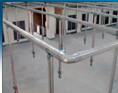
Bajante de utilización en puntos de servicio, rápidas de instalar y fáciles de modificar.
